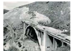
Autopista Caracas-La Guaira
