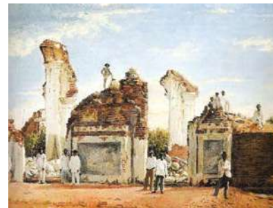
Ruinas de Cúa después del terremoto de 1882
